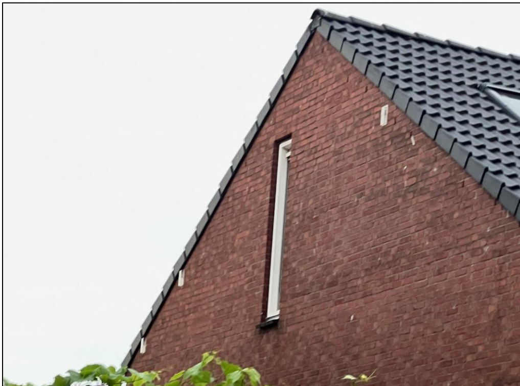
Afbeelding 11. Huis met een nieuw dak en enkele exclusion flaps.
